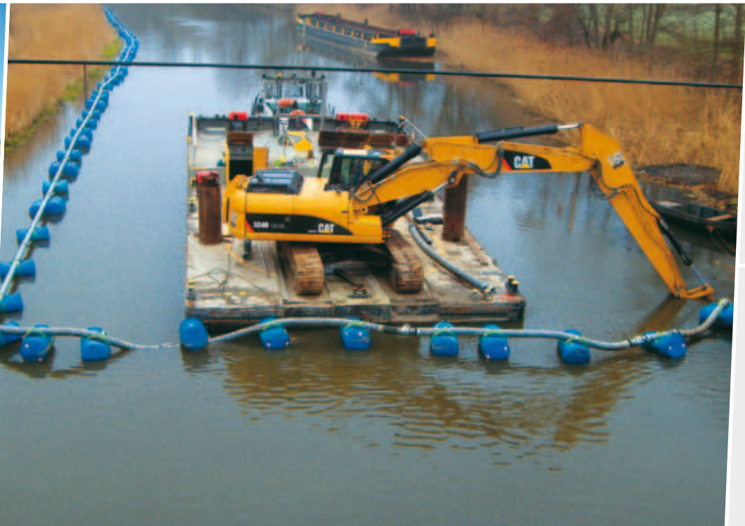
Dragage de canal avec HY85 et excavateurs - Allemagne
