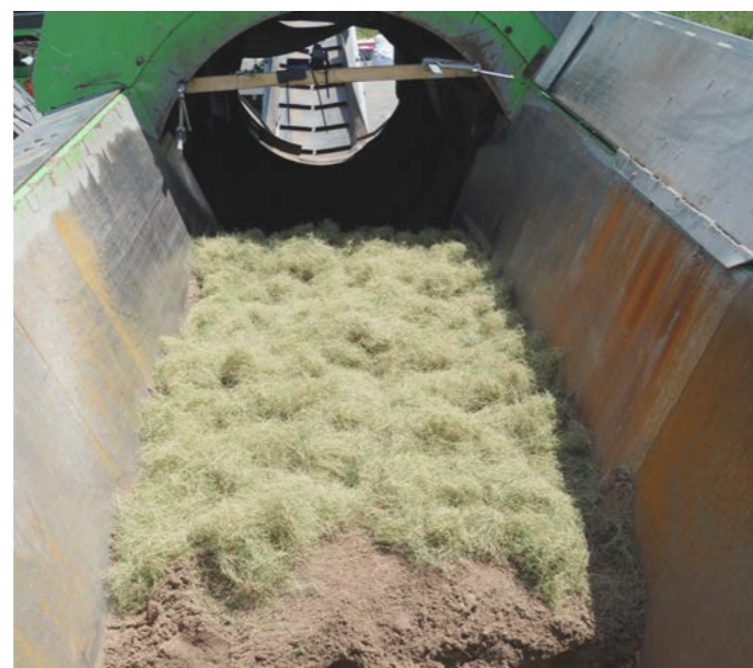
Blick in den Neuenhauser Aufgabebunker: Sand, Mutterboden und Fasern bilden die Bestandteile für eine Hybrid-Rasen-Tragschicht.
