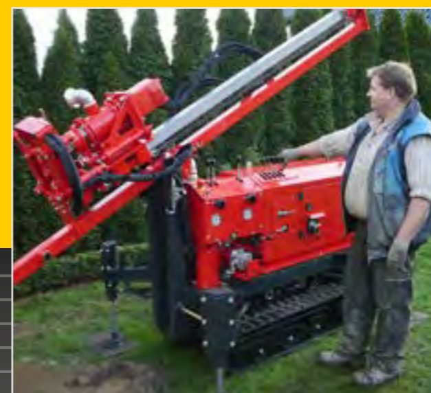
Sortie les béquilles par force hydraulique et installer le mât.
