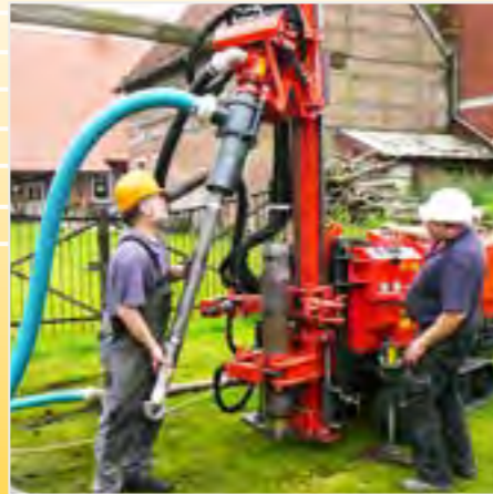
Forages tubés avec Preventer
