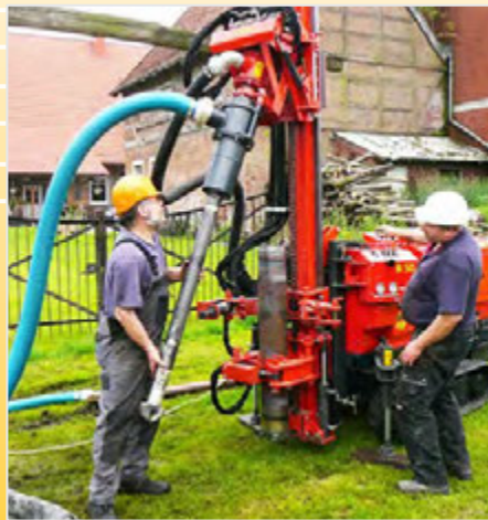
Verrohrt Bohren mit Preventer
